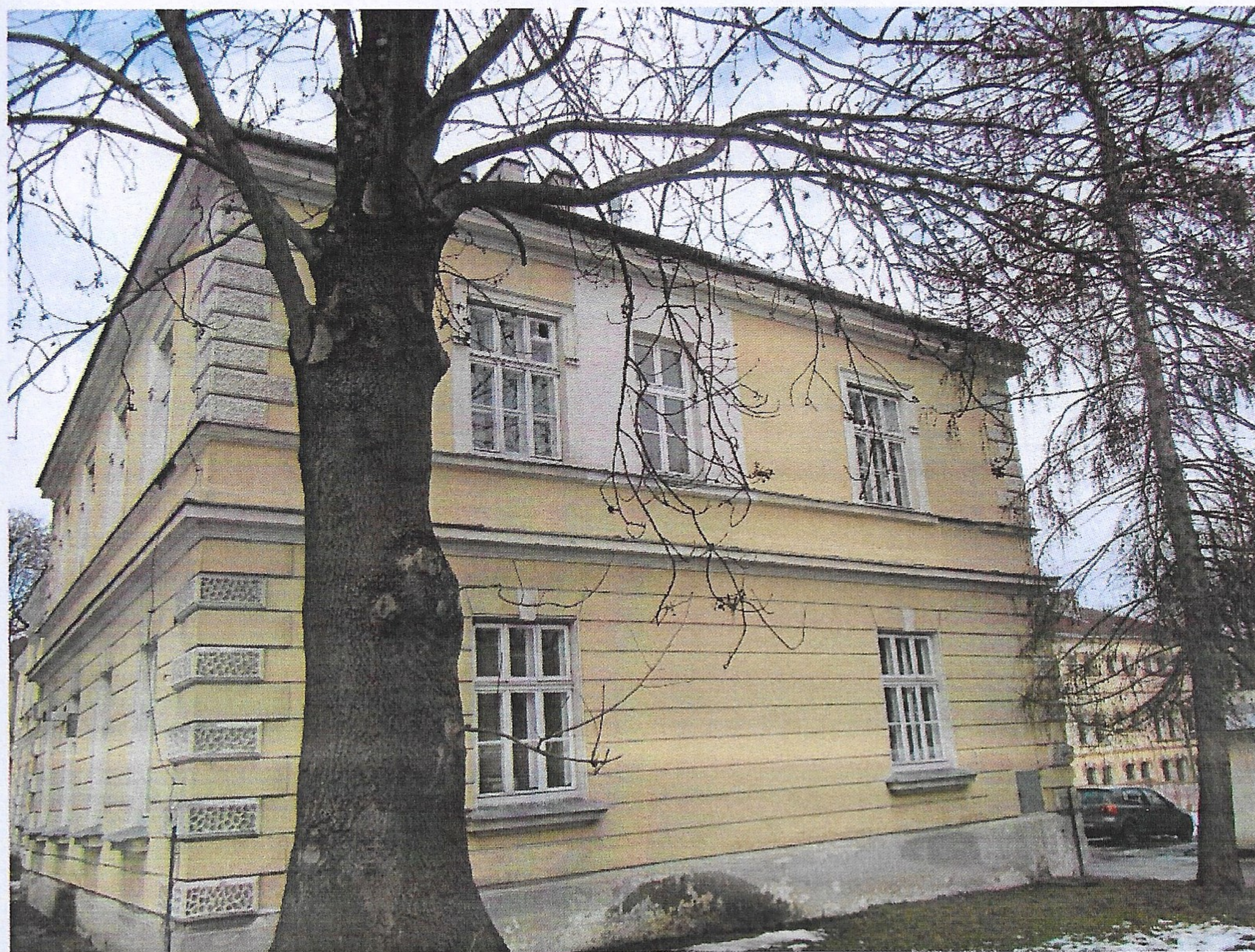
Fot.2. Fragment elewacji południowo-wschodniej
