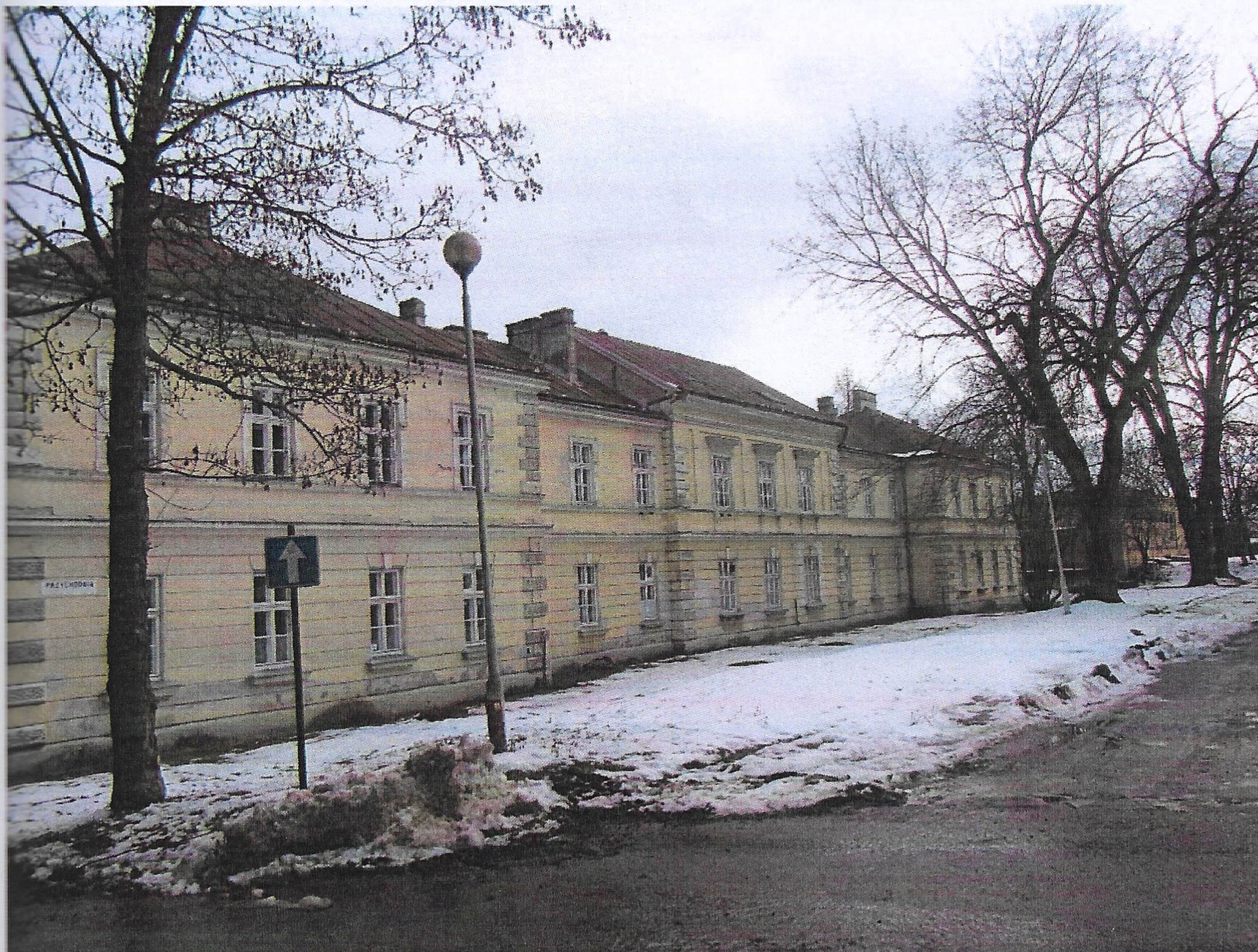
Fot.1. Elewacja południowo-zachodnia
