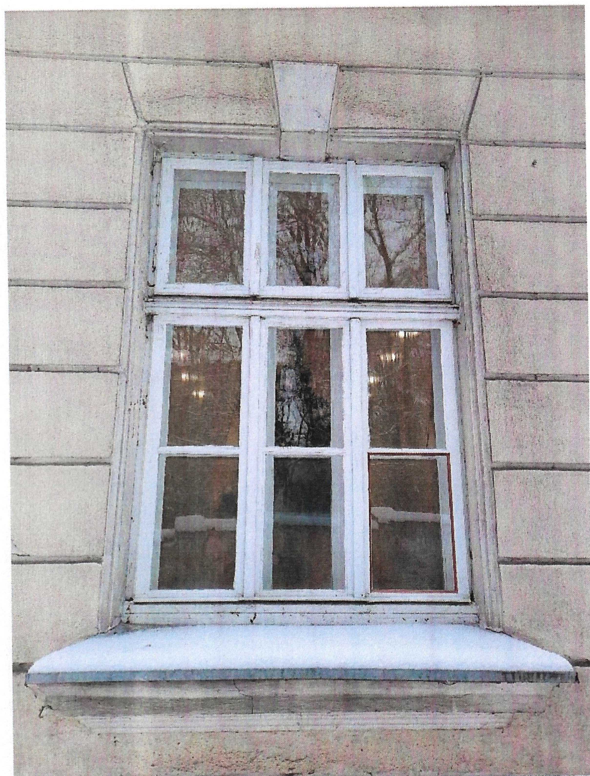
Fot.3. Okno trójdzielne – widok od zewnątrz
