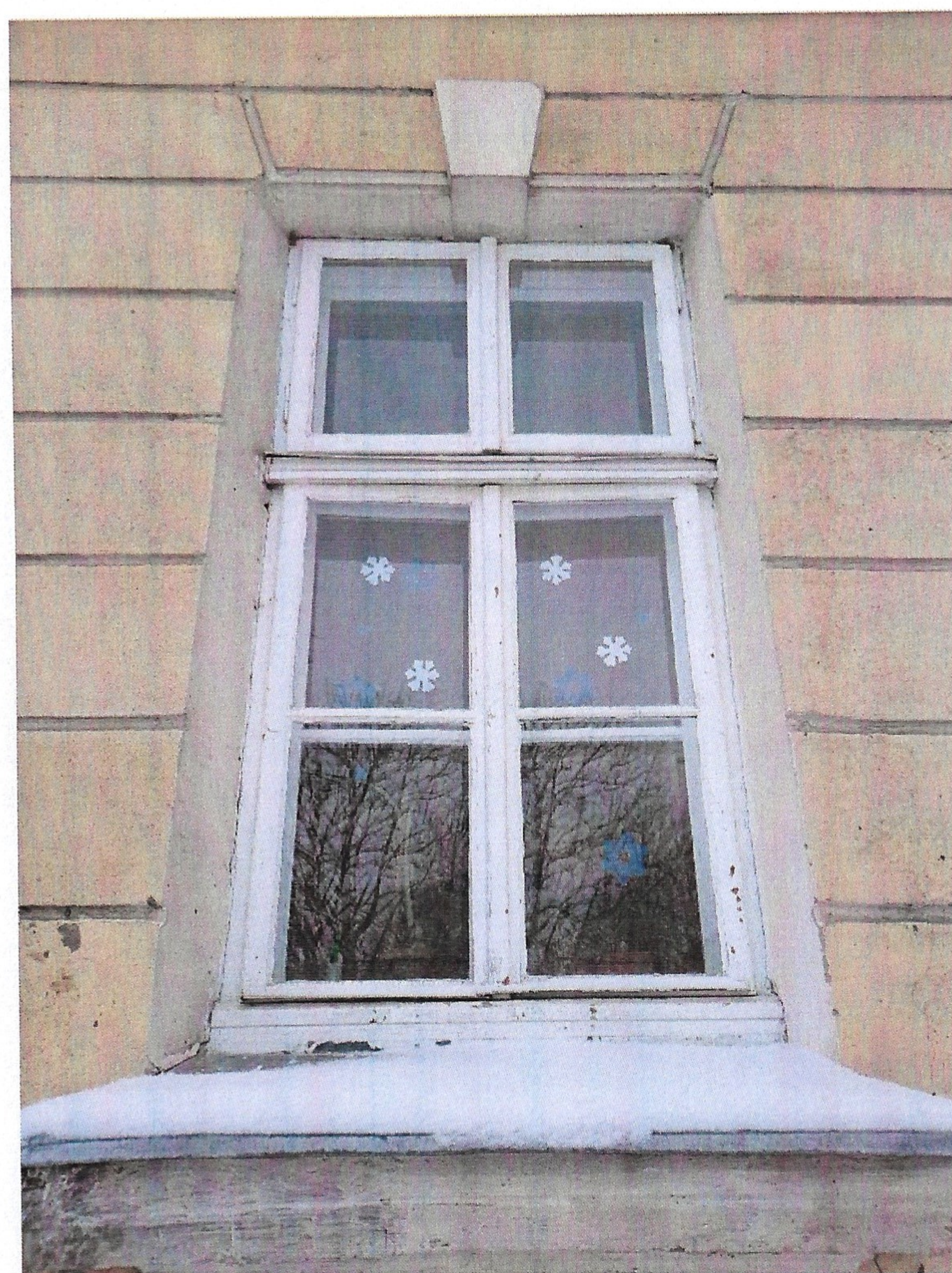
Fot.4. Okno dwudzielne – widok od zewnątrz
